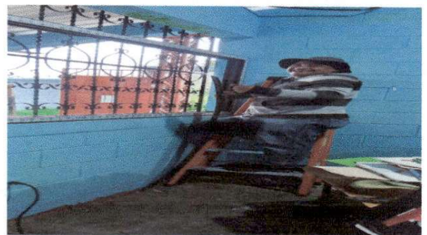
Sustitucion de ventanas de metal por pvc corredizo.
