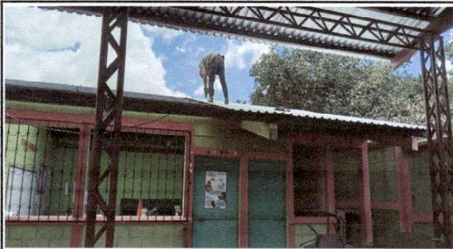
Foto 1. Cubierta de lamina
